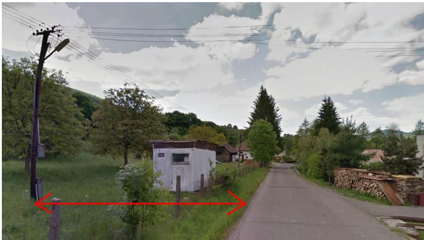
Obr. 8 Veľká vzdialenosť od osvetľovanej komunikácie, svietidlo nevhodné na osvetlenie komunikácie
