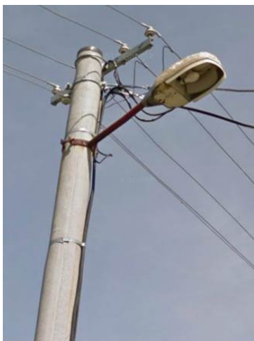
Obr. 2 Svietidlo typu „JZ“, znečistenie a korózia svietidla
