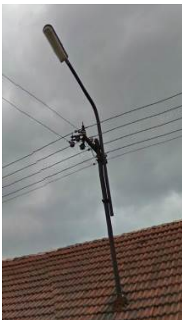
Obr. 4 Svietidlo na nástrešniku a fasáde
