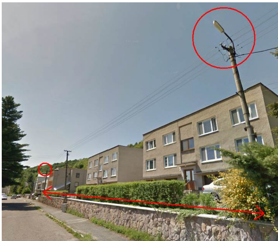
Obr. 7 Veľké rozostupy medzi svietidlami Svietidlá na každom druhom stožiar
