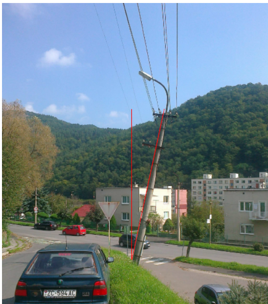
Obr. 6 Vychýlenie stožiaru
