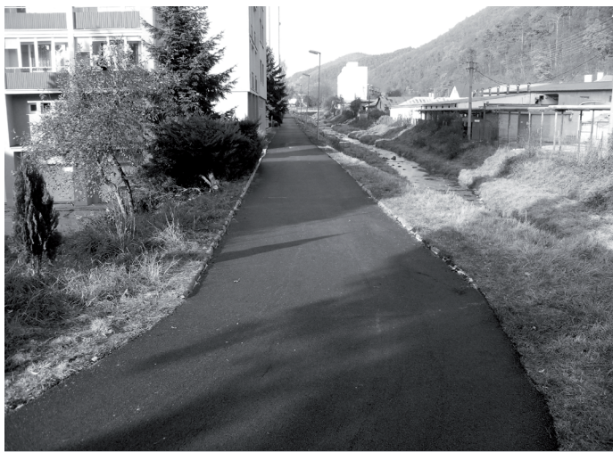
Novovasfaltovaný chodník na Nábřežnej ulici
