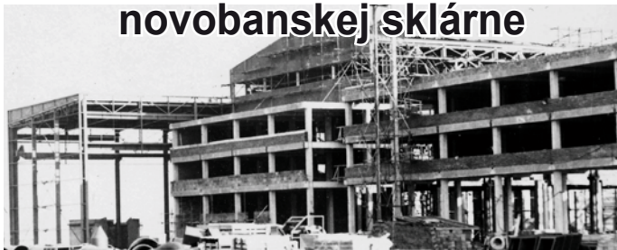
Montáž železobetónového skeletu, výstavba hutnej haly v roku 1967.
