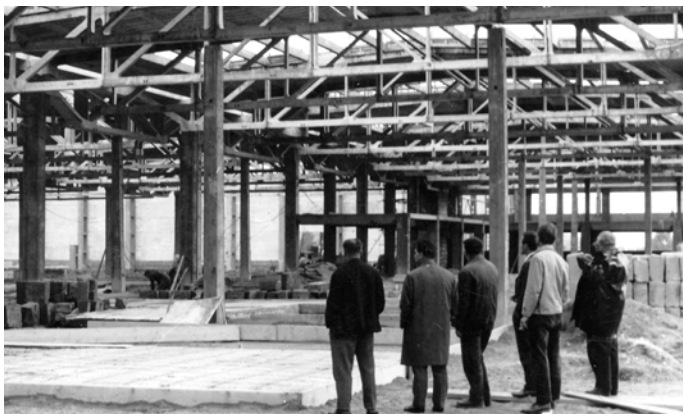
Výstavba nového závodu - kontrolný deň.
